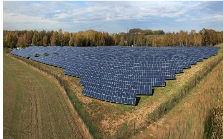
Hartmannsdorf, Germany 2,2 MW 2013
